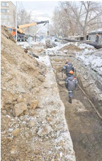
виками принято решение по поручению акима города провести внеплановый капитальный ремонт участка 200 м диаметром 325 мм, обеспечивающим технологическую связь между тепловой сетью улиц Российская и Муткенова.
