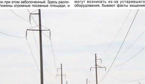
электроэнергии. Поэтому мы ежегодно меняем старый голый провод на самонесущий изолированный провод СИП в рамках инвестиционной программы. Он надежный, безопасный: меньше аварий и риск несанкционированного подключения тоже исключается. Основной упорконечно, делаем на районные центры, где больше населения. Также продолжаем программу по установке приборов учета, - говорит Алексей Кальян.
