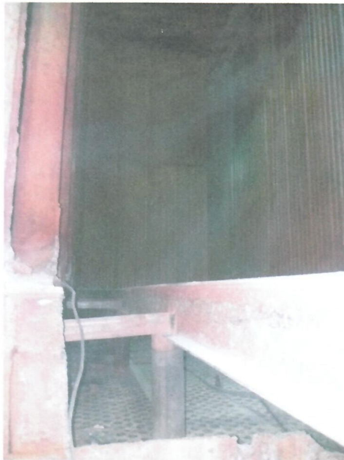
Фото №3 Смонтированный новый куб.
