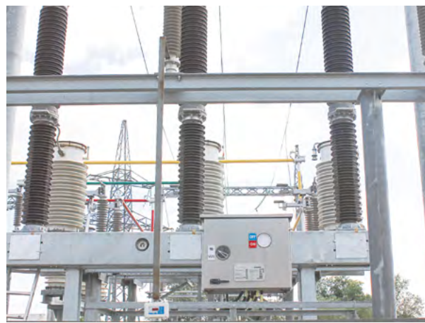
2-х реклоузуров, построение кабельной линии 10 кВ протяженностью 1,754 км, монтаж комплектов трансформаторных
